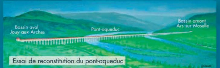
Pour traverser la vallée de la Moselle, l'aqueduc souterrain devient aérien sur 1,125 km grâce à un pont-aqueduc. Il en subsiste encore 7 arches du côté de Ars-sur-Moselle et 16 du côté de Jouy-aux-Arches.
